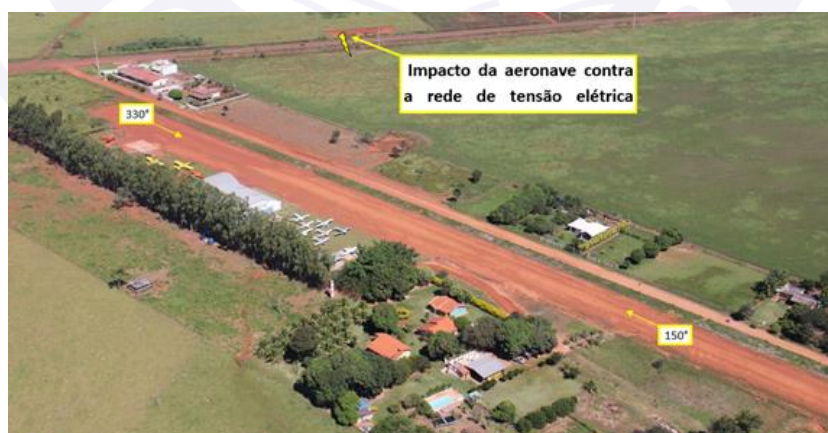
Figura 4 - Foto da pista, com a sinalização do local do acidente.
