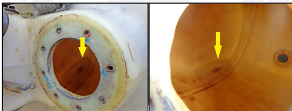
Figura 13 - Vistas do combustível remanescente no tanque.
